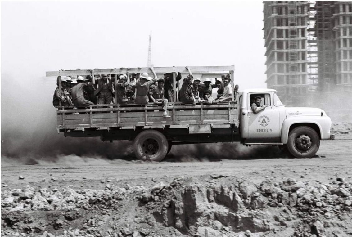
Fig. 3 - Caminhão transporta operários próximo ao futuro prédio do Congresso Nacional, 1959. Mário Fontenelle. Arquivo Público do Distrito Federal.
