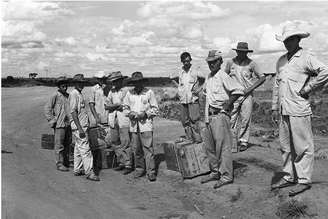
Fig. 2 - Retirantes chegam para trabalhar na construção da nova capital, 1959. Autor desconhecido.
